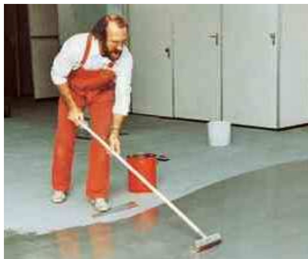
PCI Epoxigrund 390 наносится при помощи щётки на подготовленное основание.
