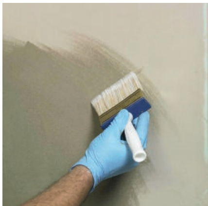
Увлажнить обрабатываемую поверхность.
