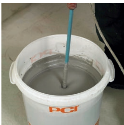
Смешать компоненты PCI Seccoral 2K Rapid до получения однородной смеси для нанесения мастерком (1 а).
