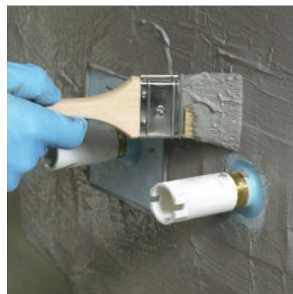
С помощью подходящего шпателя нанести второй и, возможно, третий слой до получения необходимой общей толщины покрытия.
