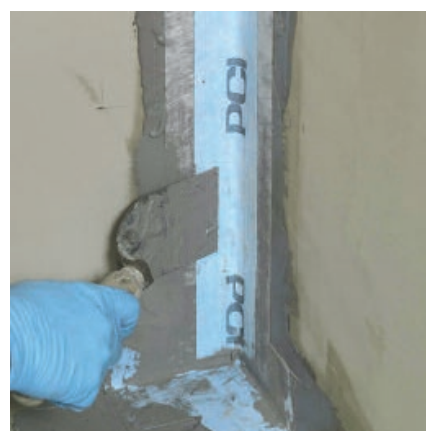
Наклеить гидроизоляционную ленту PCI Pecipare в углах.
