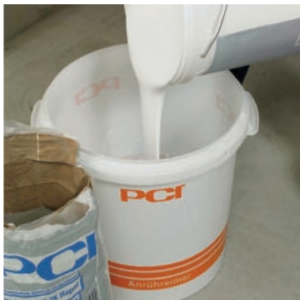
Налить жидкий компонент PCI Seccoral 2K Rapid в чистую емкость.
