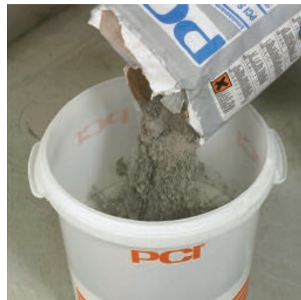
Добавить порошок PCI Seccoral 2K Rapid.
