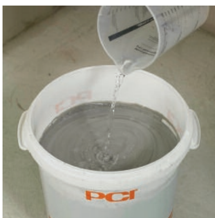
Добавить воды для нанесения валиком (1 б).
