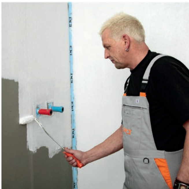
5. Нанести второй защитный слой PCI Lastogum (белого цвета), выждав время на испарение (прибл. 1 час). Первый слой PCI Lastogum (серого цвета) не должен просвечивать, иначе потребуются еще один слой.
