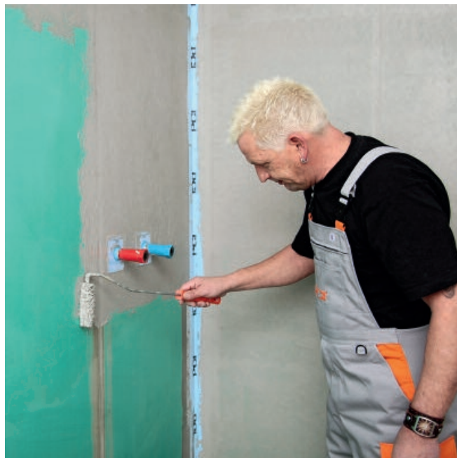
4. Нанести неразбавленный состав PCI Lastogum (серого цвета) на всю обрабатываемую поверхность в качестве первого защитного слоя.
