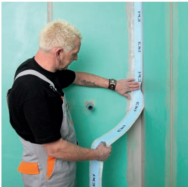
3. Зафиксировать PCI Песитаре120 с помощью PCI Lastogum (серого цвета) в угловых соединениях и соединениях пола со стенами.
