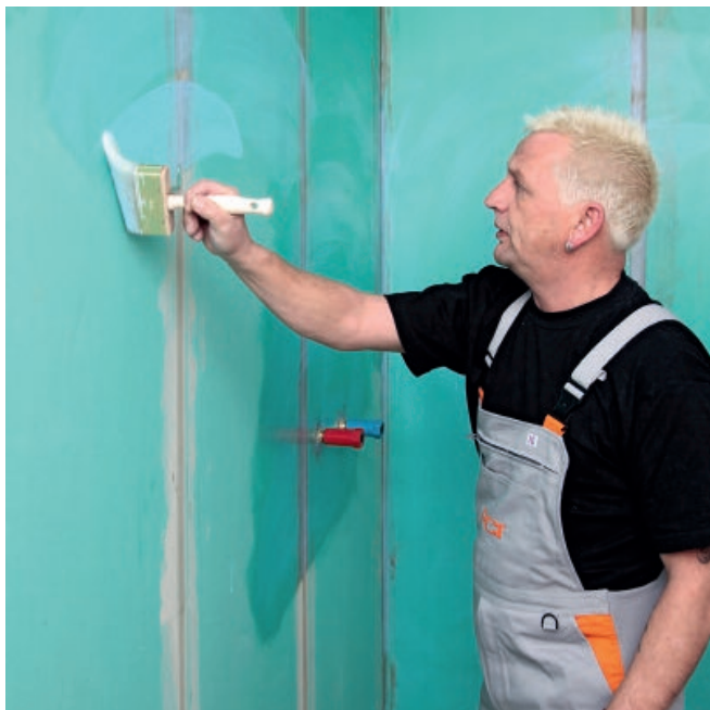
1. Для обработки впитывающих минеральных поверхностей или материалов и плит на основе гипса использовать грунтовку PCI Gisogrund.
