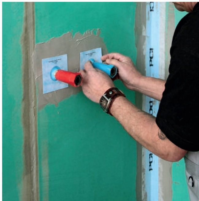
2. В местах прохождения труб через стену поместить PCI Pecipare 10×10 и покрыть составом Lastogum PCI (серого цвета).
